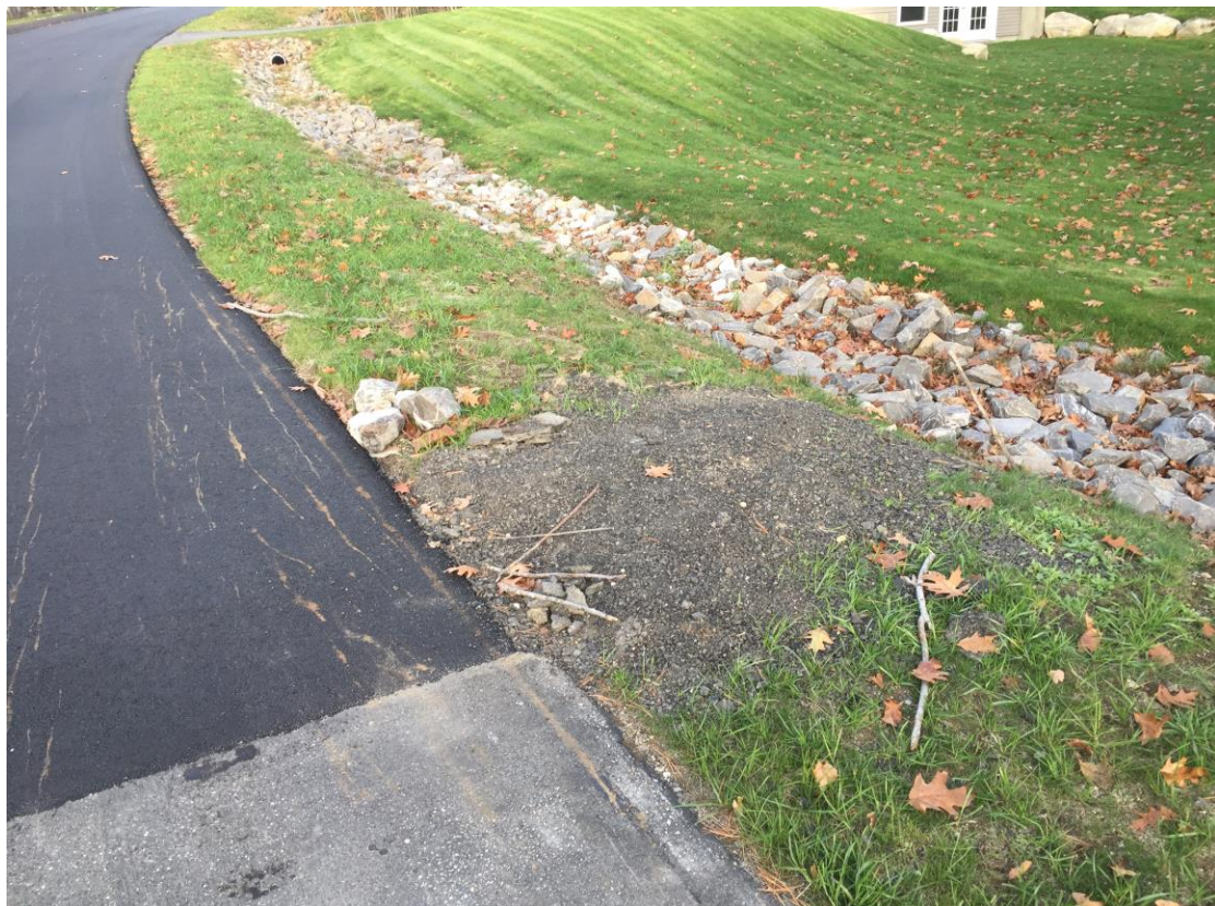
Photo 3 – Remove Pavement Millings (Sta. 38+00).
